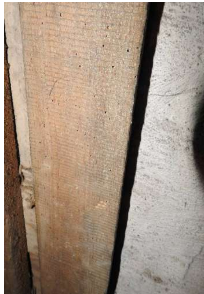
Otwory żerne kołatka domowego ( Anobium punctatum )
