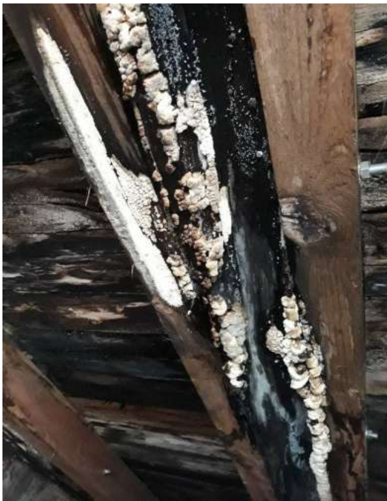
Porażenie belki grzybem domowym właściwym ( Serpula lacrymans )
