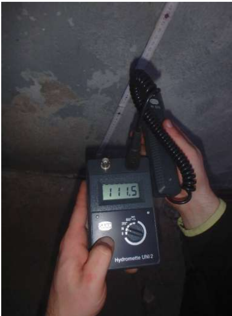
Badanie zawilgocenia podłoża
