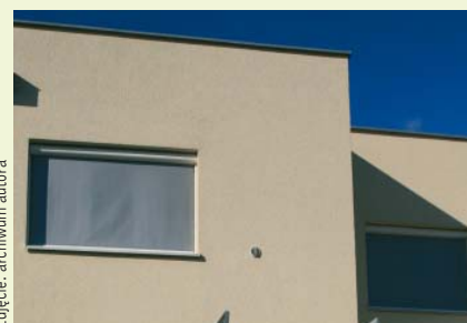
Fot. 4. Widok refleksoli z zewnątrz budynku
