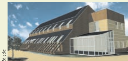
Fot. Budynek wyeksponowany na południe w celu maksymalnego wykorzystania energii słonecznej do celów grzewczych i do produkcji energii elektrycznej
