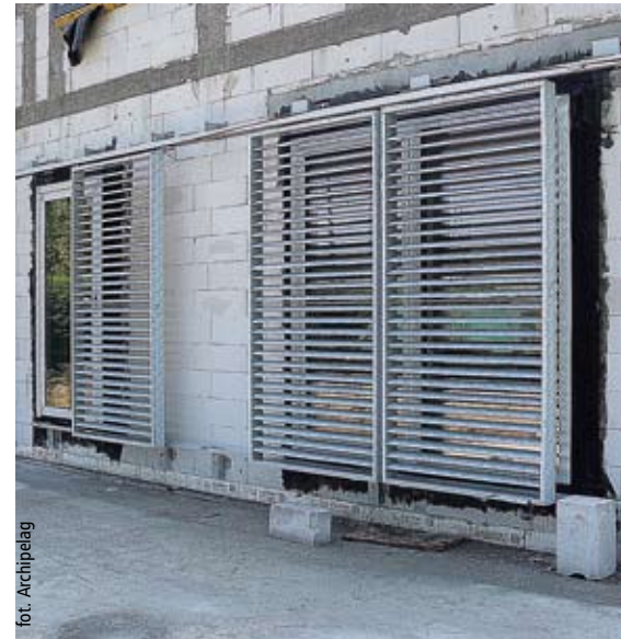
DUŻE PRZESZKLENIA strony południowej powinny być zabezpieczone przed nadmiernym nagrzewaniem np. zewnętrznymi okiennicami
