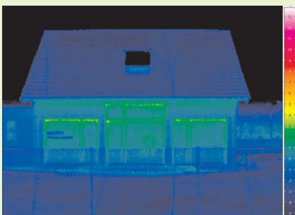
Fot. 5. Zdjęcie termowizyjne budynku pasywnego
