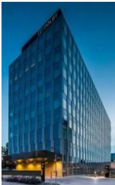
Green Towers, Wrocław SunGuard SN 51/28 Maćków Pracownia Projektowa LEED - Platinum
