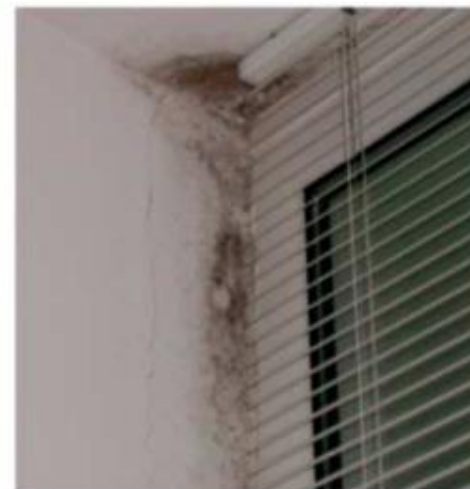
Korozja ościeża nieprawidłowo zaizolowanego
