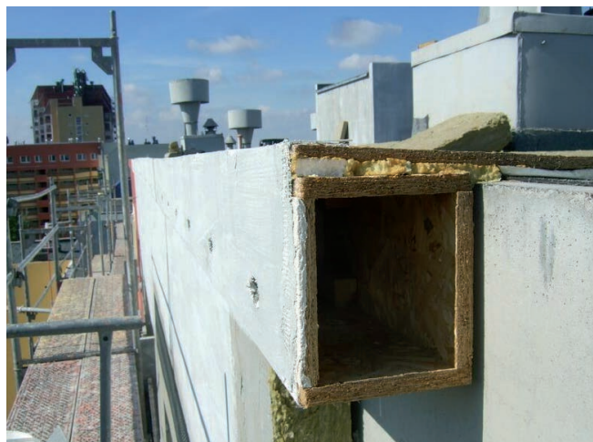
FOT. 1. Ciągłe miejsca dla ptaków ukryte w izolacji termicznej wykonane na budowie; fot.: archiwum autorów
